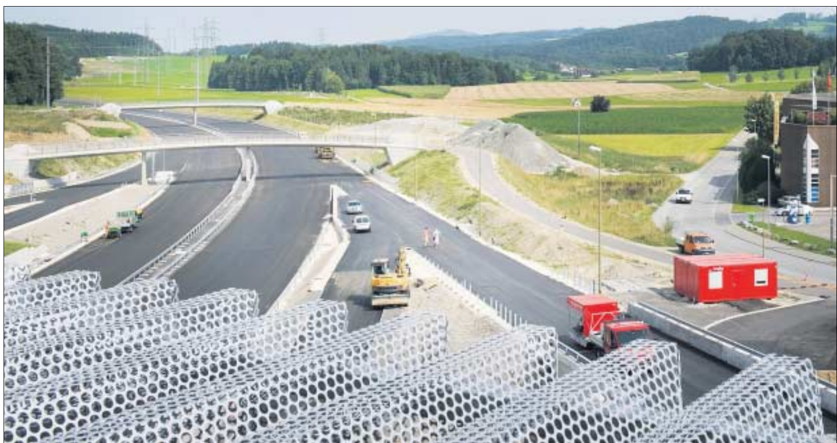
Blick vom neuen Autobahnrestaurant Affoltern a. A. Richtung Zürich: rechts der A 4 das Gebiet, in dem Fachmärkte erwünscht sind.
